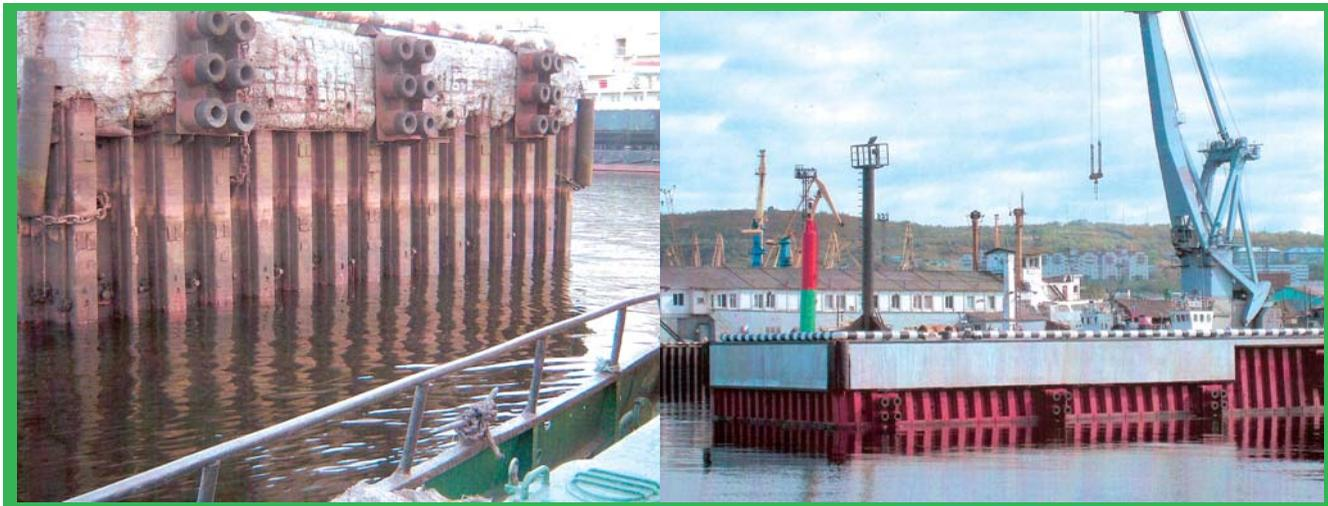
Сооружения Мурманского порта до и после обработки композицией ВВМ-М
